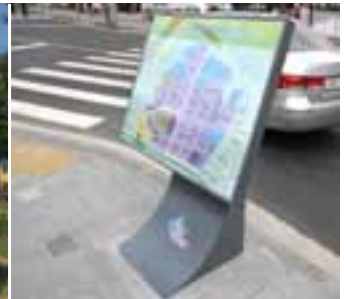
보도도경계석과 이격 설치
