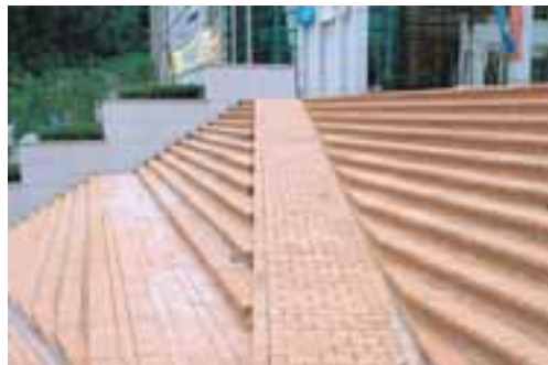
우회 경사로 설치
