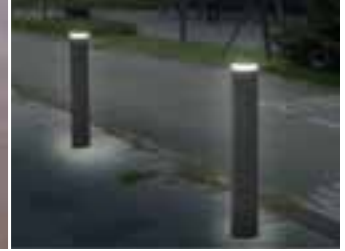
볼라드 상부 조명 설치
