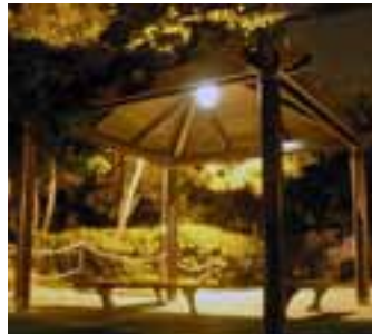
파고라 내부 조명 설치
