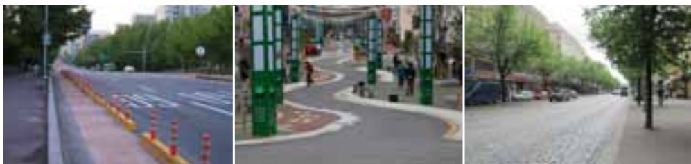
경계석이나 볼라드 설치
