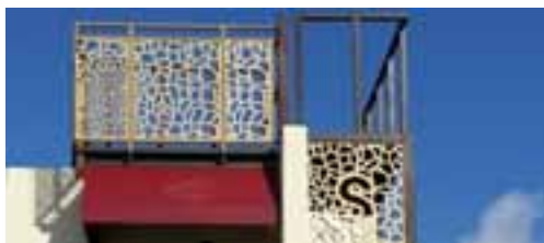
부속물의 노출 차폐 시설 설치
