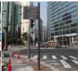
보도 경계부와 이격 설치
