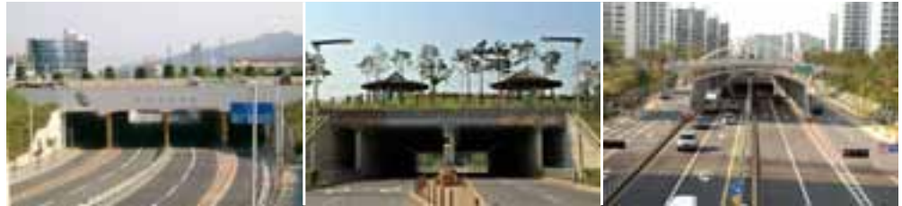
지하차도 양변에 가로등 설치
