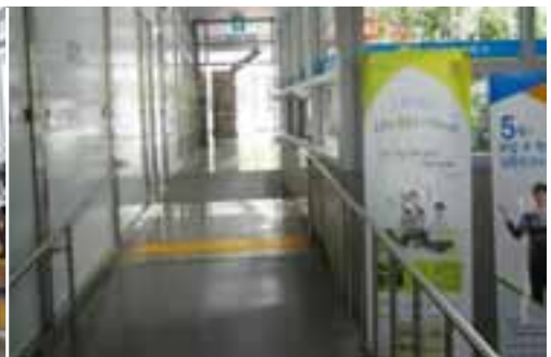
경사면과 핸드레일 설치
