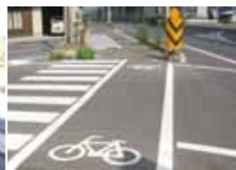
자전거 횡단보도 설치
