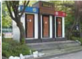
접근이 쉬운 보행가도로에 설치
