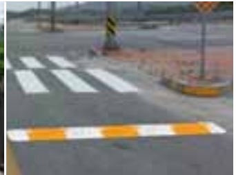
과속방지턱, 횡단보도 설치
